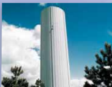
■ Traitement de l'eau
