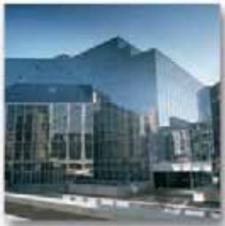
■ Gestion technique des bâtiments
